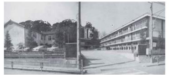
昭和33年(左)と昭和46年(右)竣工の校舎
