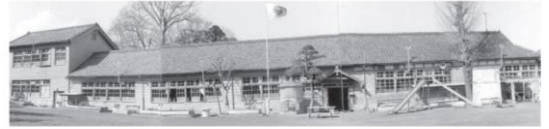
敷地北側、大正時代の建築の校舎
